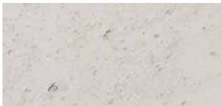
Por otro lado, la superficie de hormigón, que contiene múltiples grietas, es atacada constantemente por factores atmosféricos. Por ejemplo, con bajas temperaturas, el agua de lluvia o de rocío que suele depositarse en estas grietas puede destruir el mortero al congelarse por el aumento de volumen. Además, éste es el vehículo por el que penetran los contaminantes ácidos de una atmósfera industrial hasta las varillas de hierro del hormigón armado, y producen su oxidación y destrucción interior.
